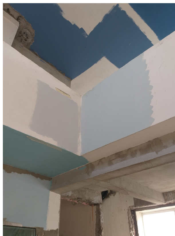
Fig. 12 - Casa del Narkomfin in corso di restauro. Ex-appartamento di Miljutin. Prove del colore. Ottobre 2019. Foto Anna Vyazemtseva.
