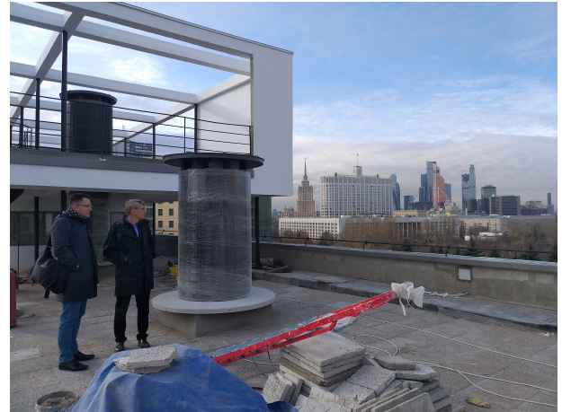
Fig. 6 - Aleksej Ginzburg e Alessandro De Magistris al cantiere di restauro della Casa del Narkomfin. Ottobre 2019 Foto Anna Vyazemtseva.
