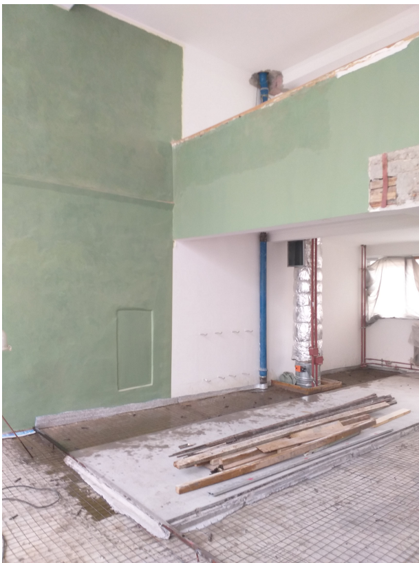
Fig. 14 - Casa del Narkomfin in corso di restauro. Indagini sulla soluzione cromatica degli ambienti. Ottobre 2019. Foto Anna Vyazemtseva.
