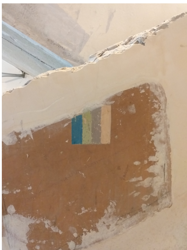
Fig. 11 - Casa del Narkomfin in corso di restauro. Indagini sulla soluzione cromatica degli ambienti. Ottobre 2019. Foto Anna Vyazemtseva.
