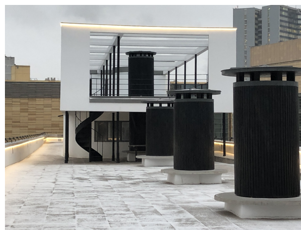
Fig. 3 - Tetto-terrazzo. Spazio comune. Foto Ginzburg Architects © Ginzburg Architects.
